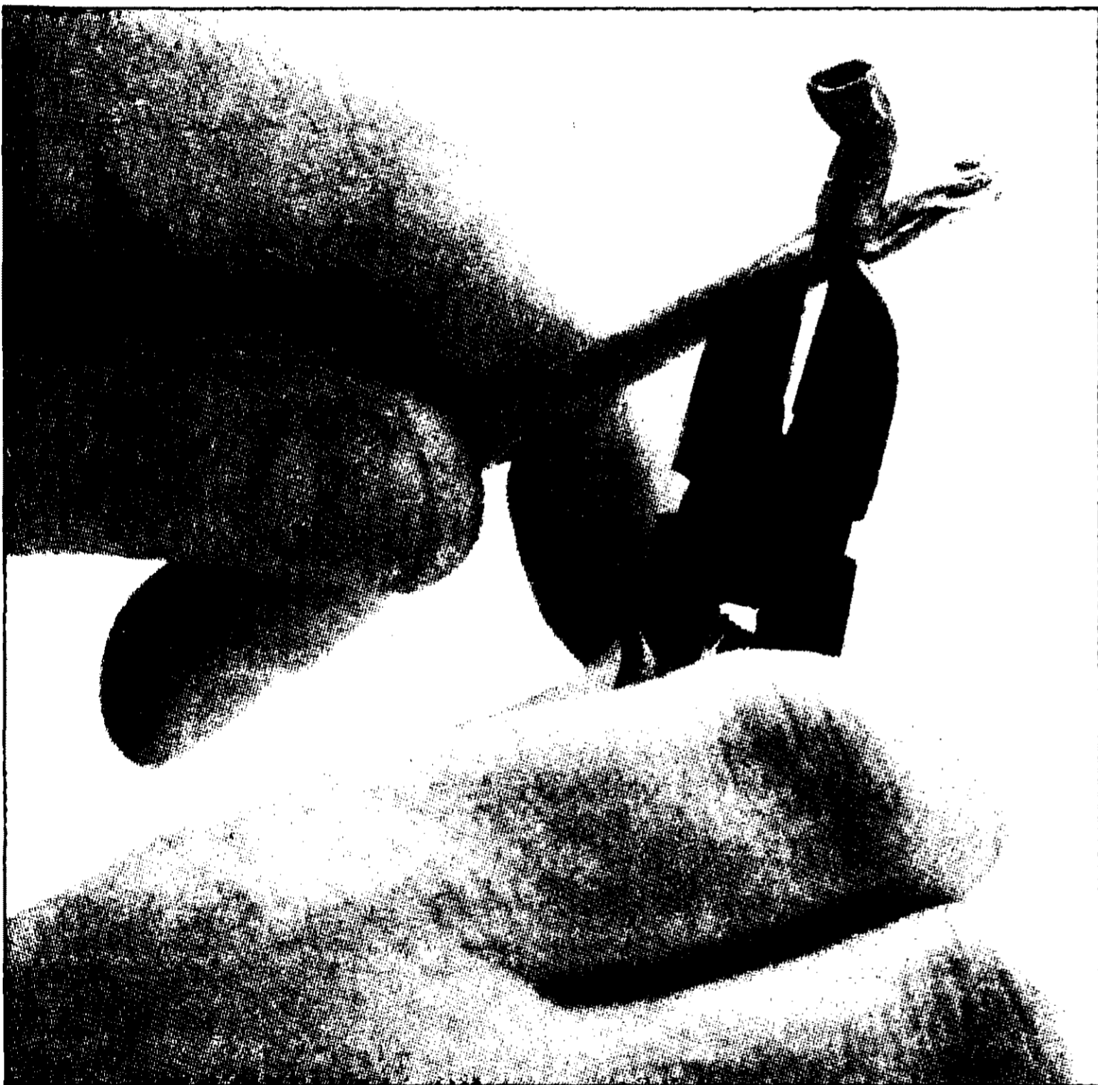
Рис. 17.12. Аккуратно снимите внешнюю изоляцию, чтобы открылись четыре пары проводов
