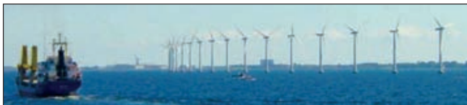
Вітрова електростанція. Данія
