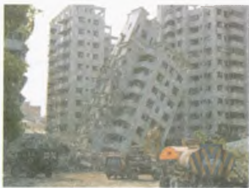
Іл. 30.1. Наслідки землетрусу
