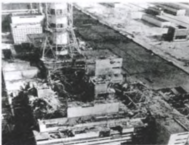
Іл. 30.13. Аварія на Чорнобильській АЕС
