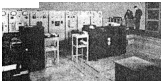
Рис. 1.12. Перший комерційний комп'ютер LEO (1951р.)
