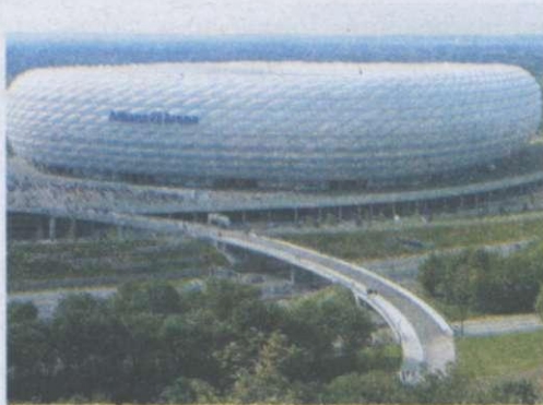
Алліану-Арена. м. Мюнхен (Баварія)
