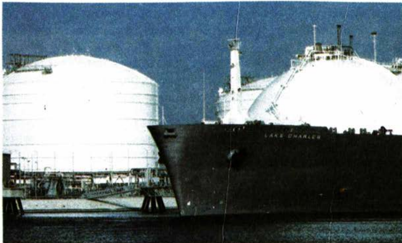
Мал. 25. Резервуар для зберігання скрапленого природного газу
