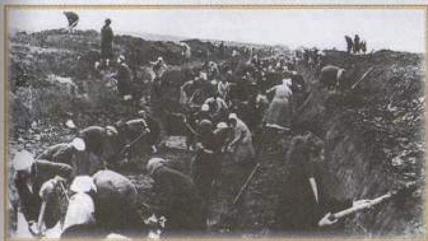
Робота над будівництвом оборонних споруд
